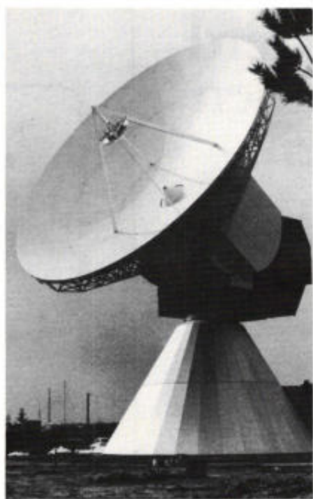
Afb. 4. Schotelantenne van een satellietgrondstation in Usingen in de omgeving van Frankfurt/Main, gericht op een Intelsat V satelliet geschikt voor het frequentiegebied van 11...14 GHz.
